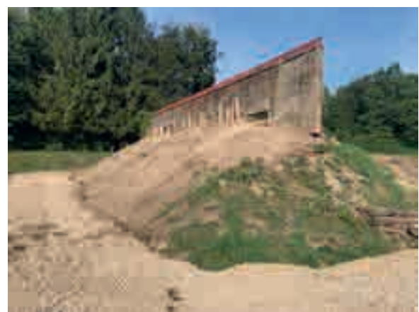
Sanierter Kugelfang Rückseite, vor der Wiederherstellung
