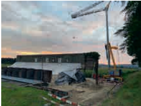
Schutzmauer, Verbreiterung mit Eisenbahnschwellen
