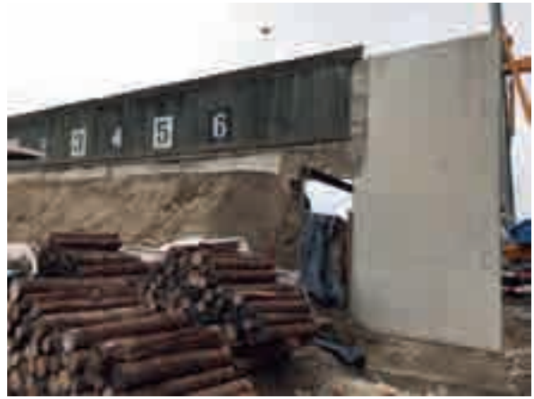
Schutzmauer, Verbreiterung mit Betonelement
