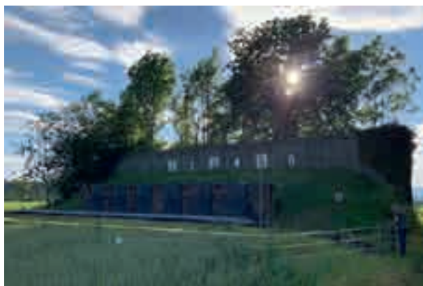
Kugelfang vor der Sanierung
