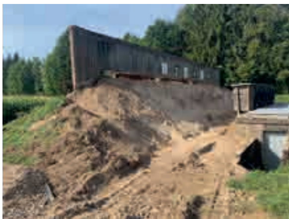
Sanierter Kugelfang Vorderseite, vor der Wiederherstellung
