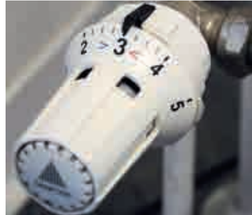
Thermostatventil zur Regelung der Raumtemperatur
