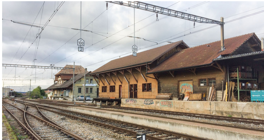
Abb. 7 Areal der ZPP Nr. 15 «Bahnhof Nord» von Süden her gesehen (12. September 2017)
