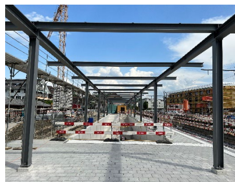
Aufrichte Perrondach Gleis 1
